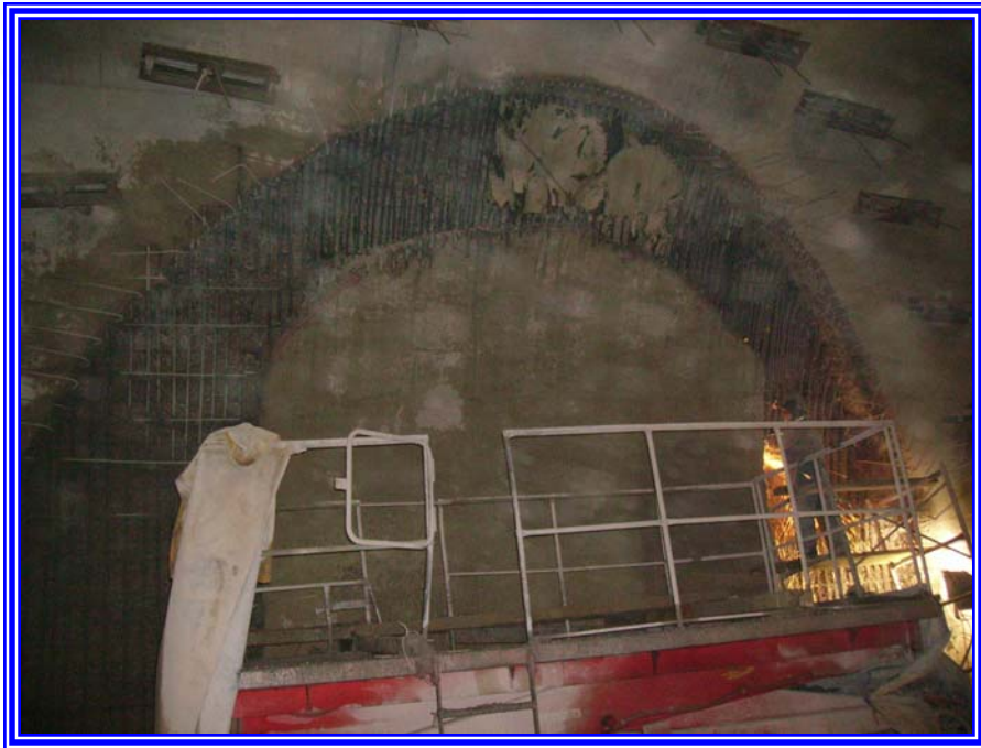
Υδροκοπή της μόνιμης επένδυσης του υφισταμένου κλάδου και κοπή του αποκαλυφθέντος σιδηροπλισμού
