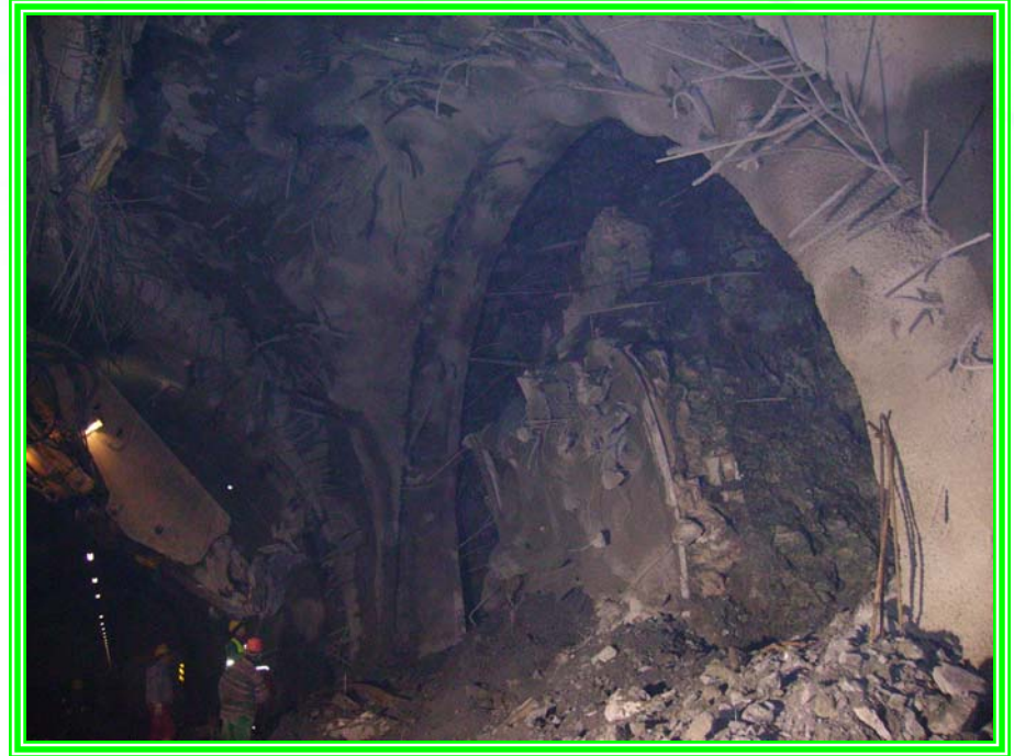
Καθαίρεση των υπολειμμάτων της μόνιμης επένδυσης στην περιοχή αλληλοτομίας και έναρξη εκσκαφής των συνδετηρίων στοών.
