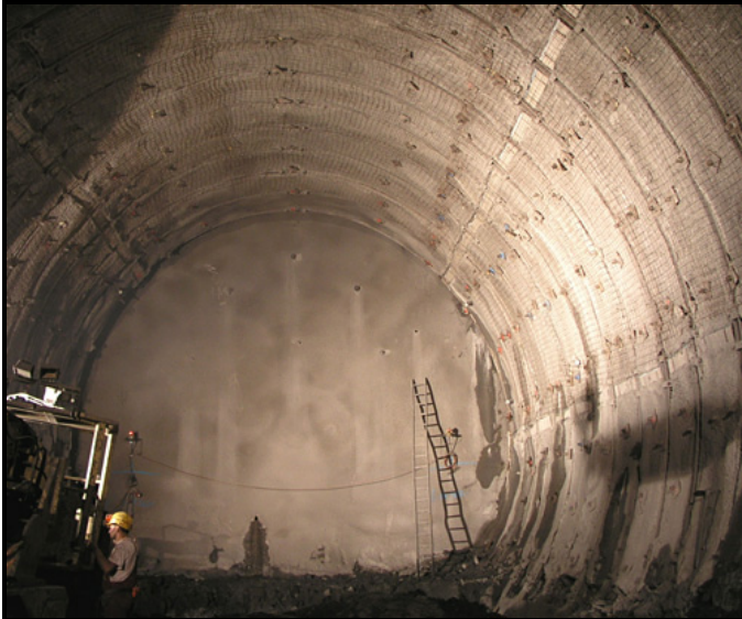
Σιδ/κή σήραγγα Lötschberg
