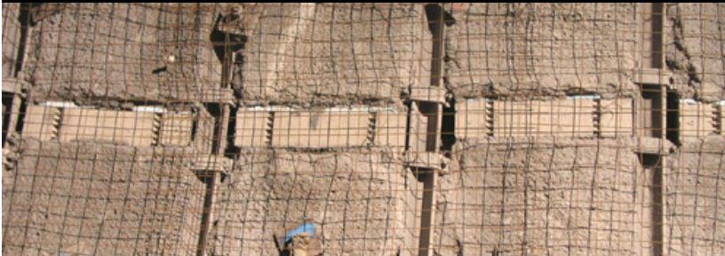
Σιδ/κή σήραγγα Lötschberg
