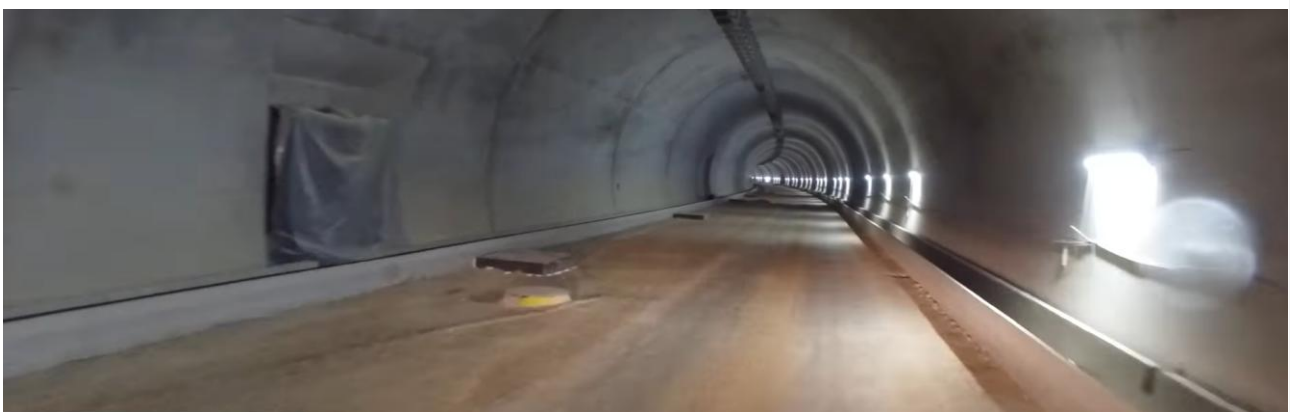
Η σήραγγα Αμπελιάς
