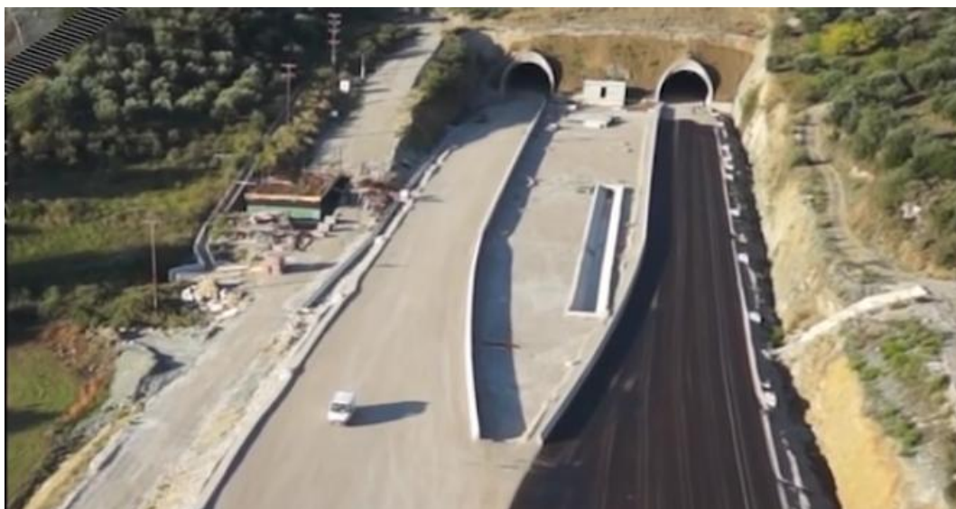
Είσοδος σήραγγας Καλυδώνας (Ιόνια Οδός)
