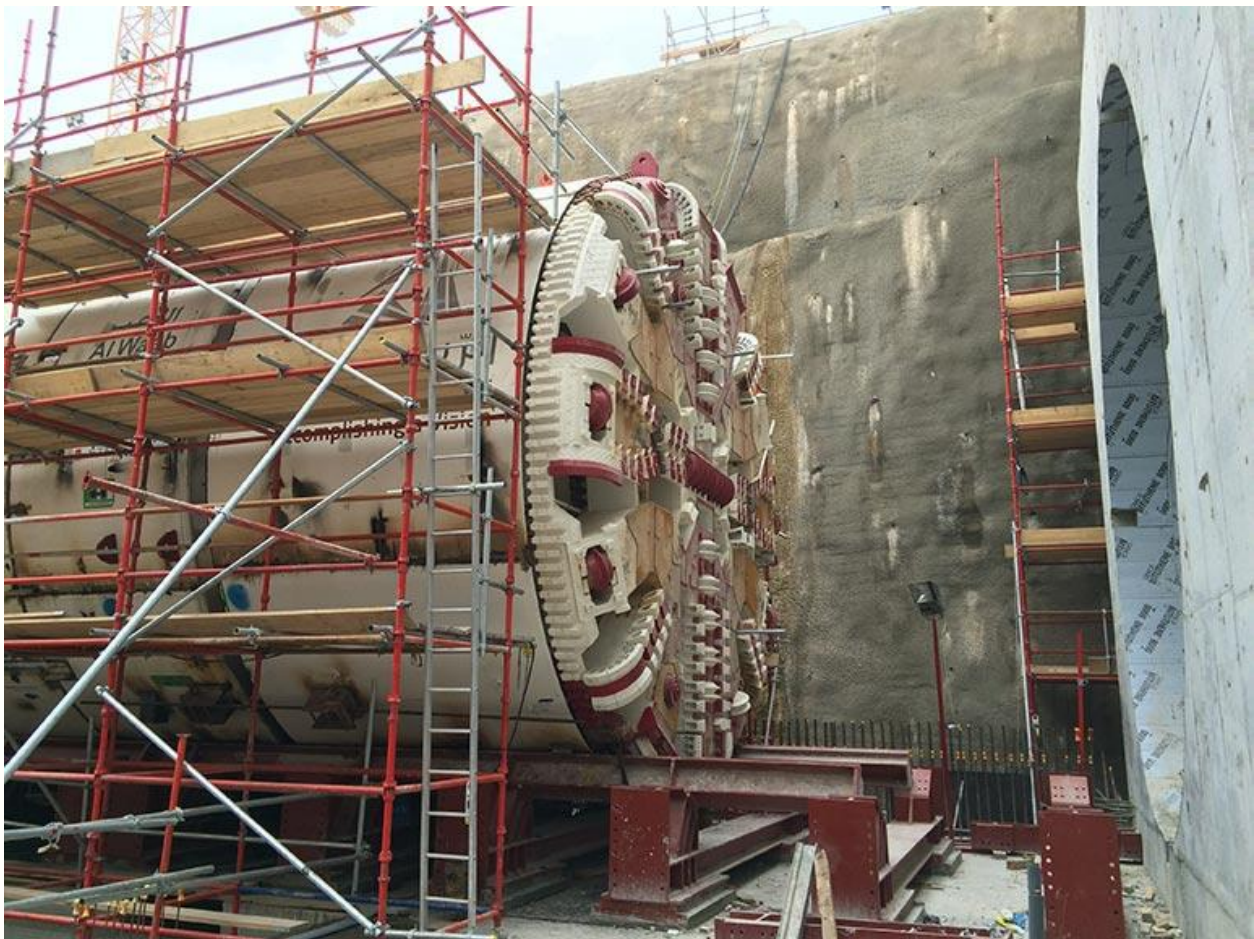
Το TBM Al Waab στον σταθμό εκκίνησης. Πηγή www.bing.com/ images
