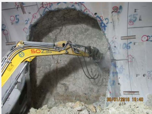
Άνοιγμα στην επένδυση σε θέση όπου έχουν προηγηθεί τσιμεντενέσεις για μείωση υδροφορίας.
