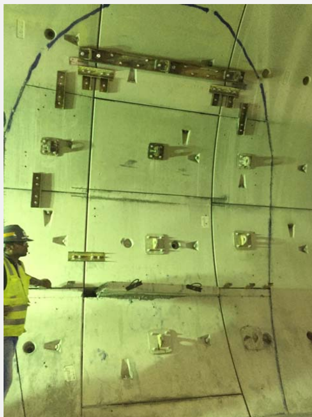
Προκατασκευασμένα στοιχεία μετά την κοπή και πριν την καθαίρεση. Εφαρμόσθηκαν επιπρόσθετα μεταλλικές γωνιές για προσωρινή συγκράτηση μεταξύ των προκατασκευασμένων
