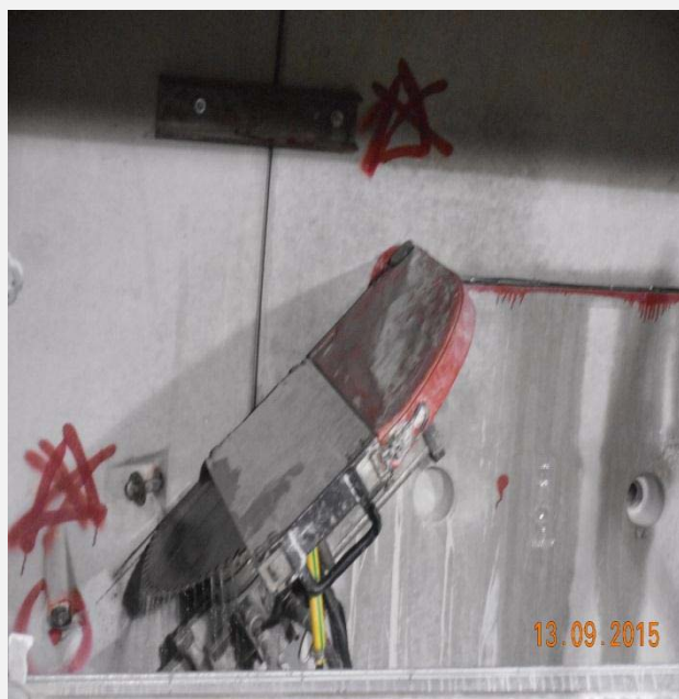
Κοπή των προκατασκευασμένων
