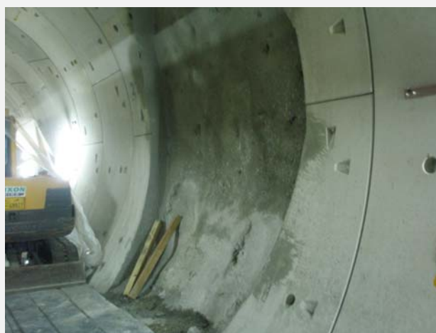
Μέτωπο ανοίγματος μετά την καθαίρεση και πριν την έναρξη εκσκαφής της συνδετήριας σήραγγας
