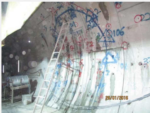
Περιοχή ανοίγματος μετά από τσιμεντενέσεις και δοκιμαστικές διατρήσεις για μέτρηση εισροών
