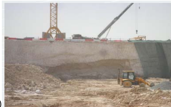
Σχήμα 4. Ασβεστόλιθος Simsima. (α) Καρστικό έγκοιλο με υλικό κατάπτωσης, (β) και (γ) Ανοικτά καρστικά έγκοιλα
