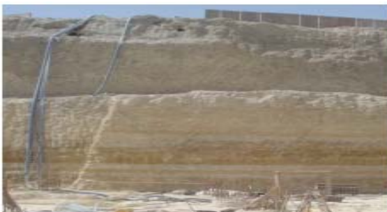
Σχήμα 2. Στρωσιγένεια του βραχώδους υποβάθρου. Διακρίνεται η καφέ χρώματος ιλυολιθική στρώση (Midra Shale) μεταξύ των ασβεστολιθικών στρώσεων (Simsima Limestone και Rus formation).
