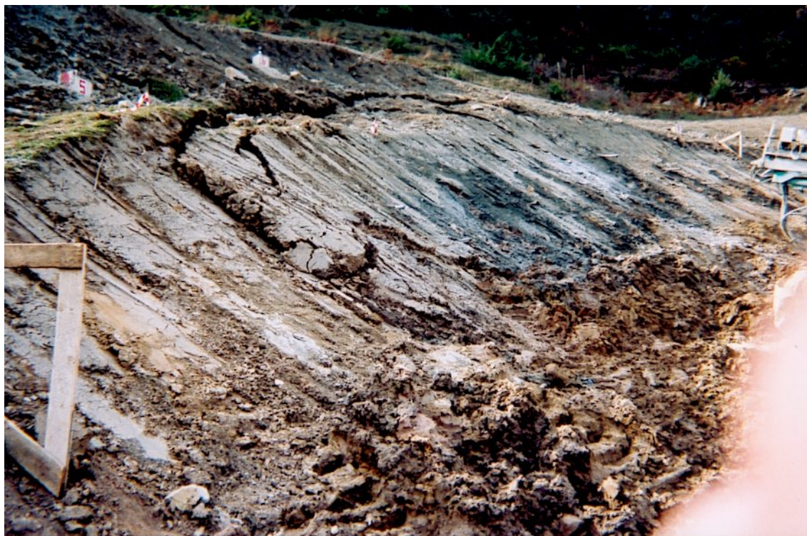
Φωτ. 1 και 2: Αποκόλληση (ρηγμάτωση) του άνω τμήματος του Νότιου πρανούς κάτω από του στόχους Σ5 και Σ6, με σύγχρονη εμφάνιση μεγάλης υδροφορίας (η οποία όμως εκτονώθηκε σύντομα).
