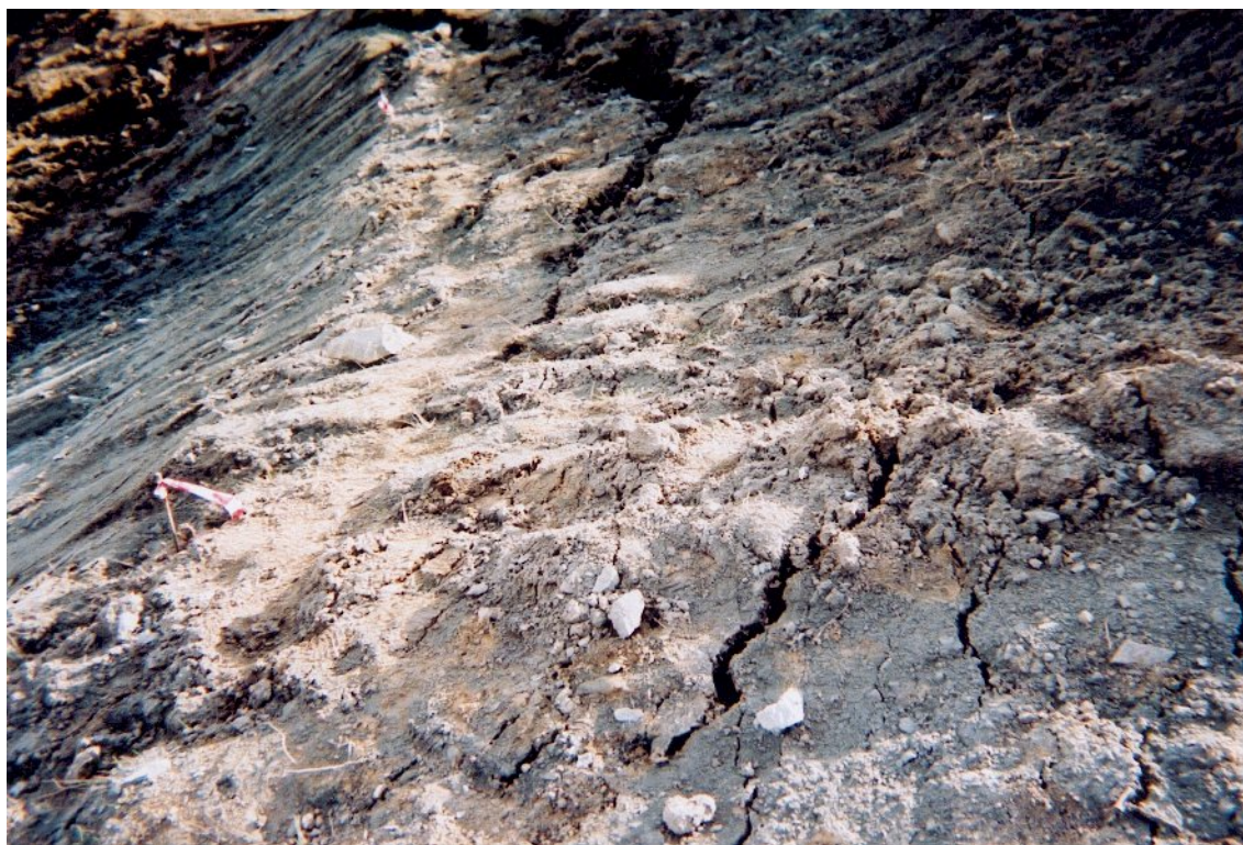
Φωτ. 1 και 2: Αποκόλληση (ρηγμάτωση) του άνω τμήματος του Νότιου πρανούς κάτω από του στόχους Σ5 και Σ6, με σύγχρονη εμφάνιση μεγάλης υδροφορίας (η οποία όμως εκτονώθηκε σύντομα).
