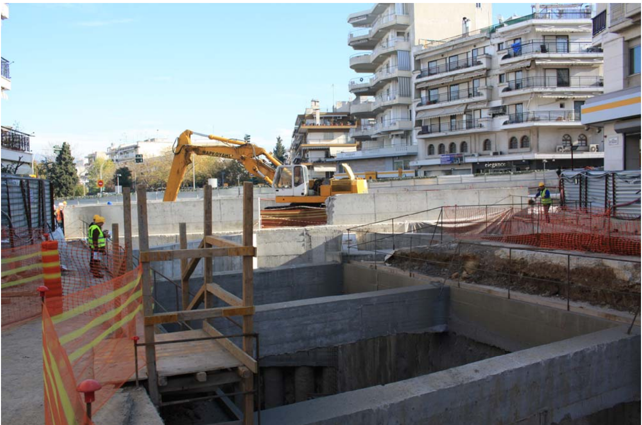
Αντιστήριξη του ανοιχτού ορύγματος στο σταθμό Καλαμαριά
